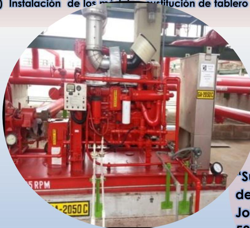
AÑO 2015 Al servicio de la empresa COISSO SA de CV. para atender al Contrato de adquisición de bienes inmuebles a precio fijo No 4500512178. "Suministro de módulos (ECM) de principal y alternativo Mca John Deere No. de parte Re-507981.) Instalación de los módulos, sustitución de tablero de control y puesta en marcha del equipo GA-2050 C.
