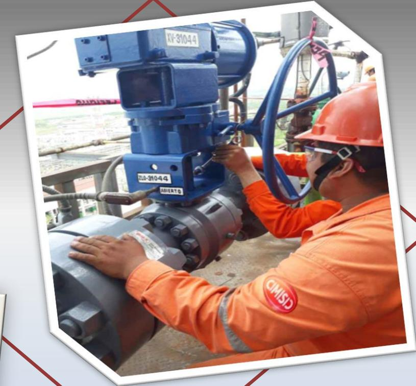
**Cit-094/2017/13002-17 servicio para desmontaje y montaje de todos los componentes del sistema de corte para su mantenimiento (cartucho de bomba jet, juntas rotatorias, barrenas, malacates, mangueras, válvulas de aislamiento, válvula de control) en la planta U-31000 del sector 8, en el interior de refinería Gral. Lázaro Cárdenas .**
